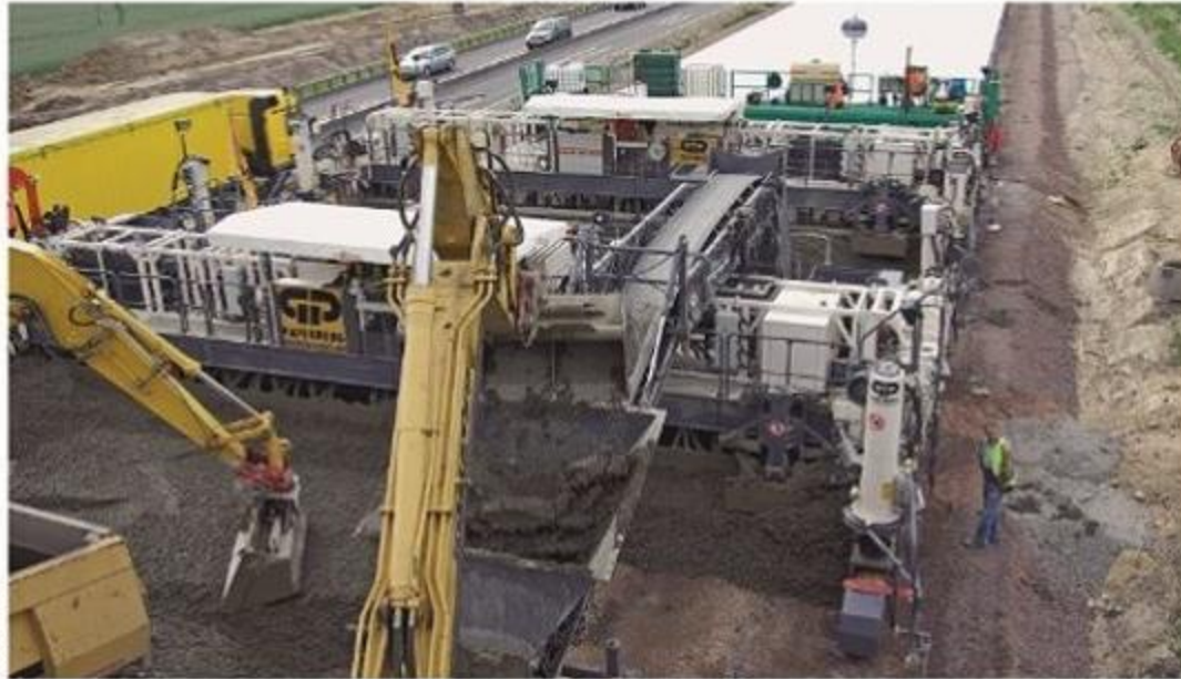
Bild 5.22: Gleitschalungsfertiger für Unter- und Oberbeton sowie Nachlaufbühne zum Aufbringen des Oberflächenverzögerers
