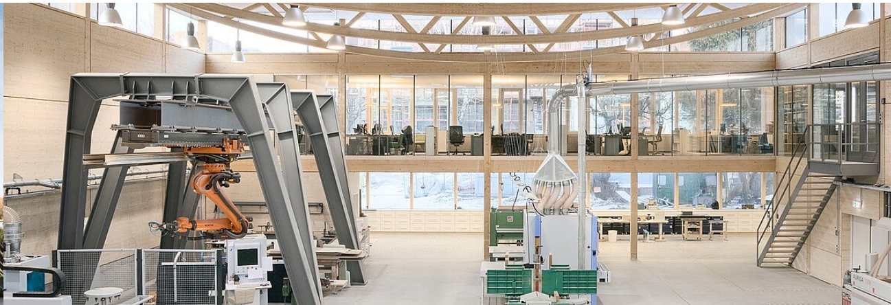
CO2 positiv: Werkhalle Berlin - ZRS Architekten und Ingenieure
